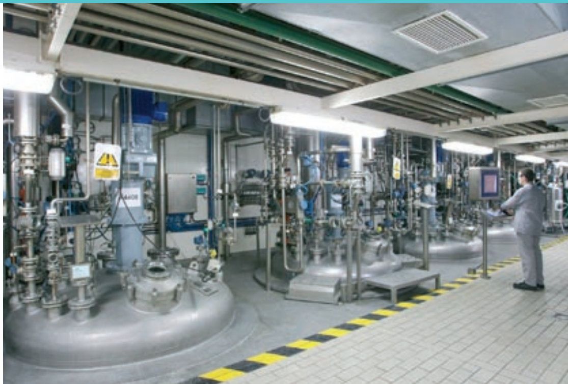
Interior de les instal·lacions de Sandoz Industrial Products, del grup Novartis, a les Franqueses
