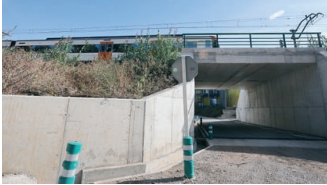
El nou pas del camí de Ca l'Esquella, al sud de Granollers, ha permès eliminar el pas a nivell del camí antic de Parets
