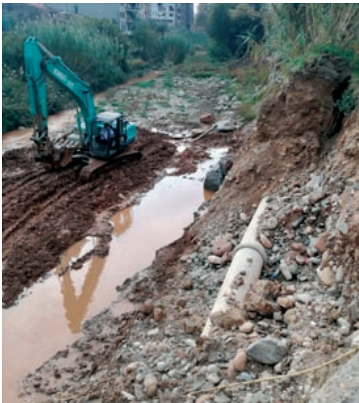
Els treballs per protegir el col·lector que va quedar descalçat
