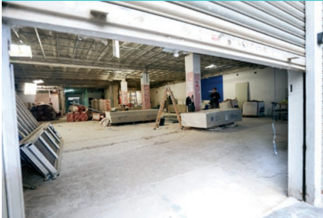
Les obres al local que ocuparà el nou Viena han començat en les últimes setmanes
