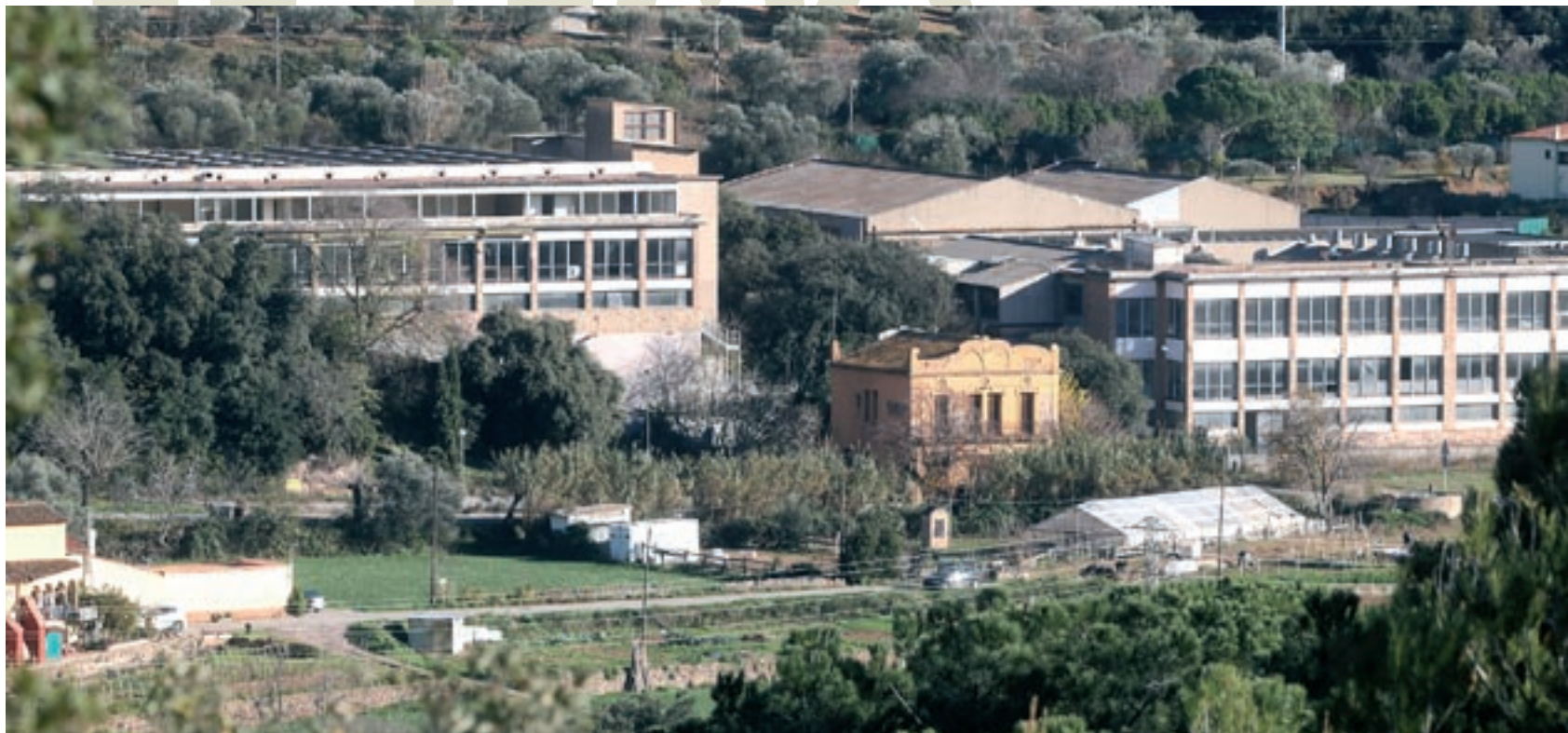
Les empreses que han comprat la parcel·la de l'antiga Sati ja han presentat el projecte d'enderroc per aconseguir la llicència municipal. Conservarà la casa modernista al peu de l'
