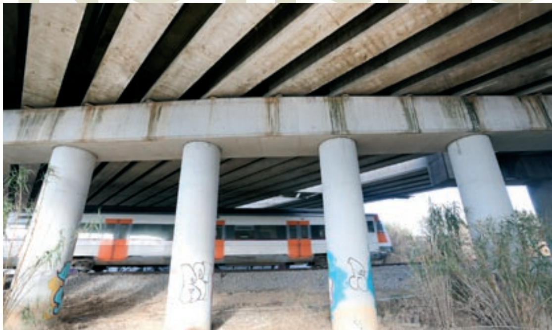
Un tren de la línia de Vic passant per sota del viaducte del corredor de mercaderies del Vallès i l'R8, a tocar de la Llagosta
