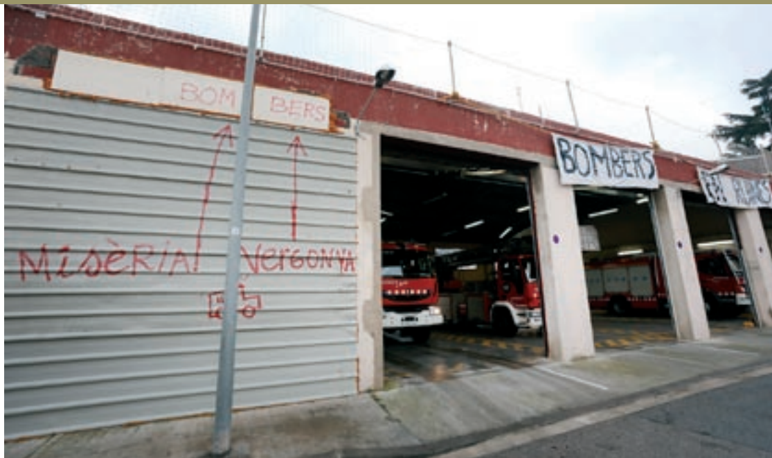
La cinquena porta de la cotxera ja està oberta però encara no està operativa i va quedar tancada provisionalment
