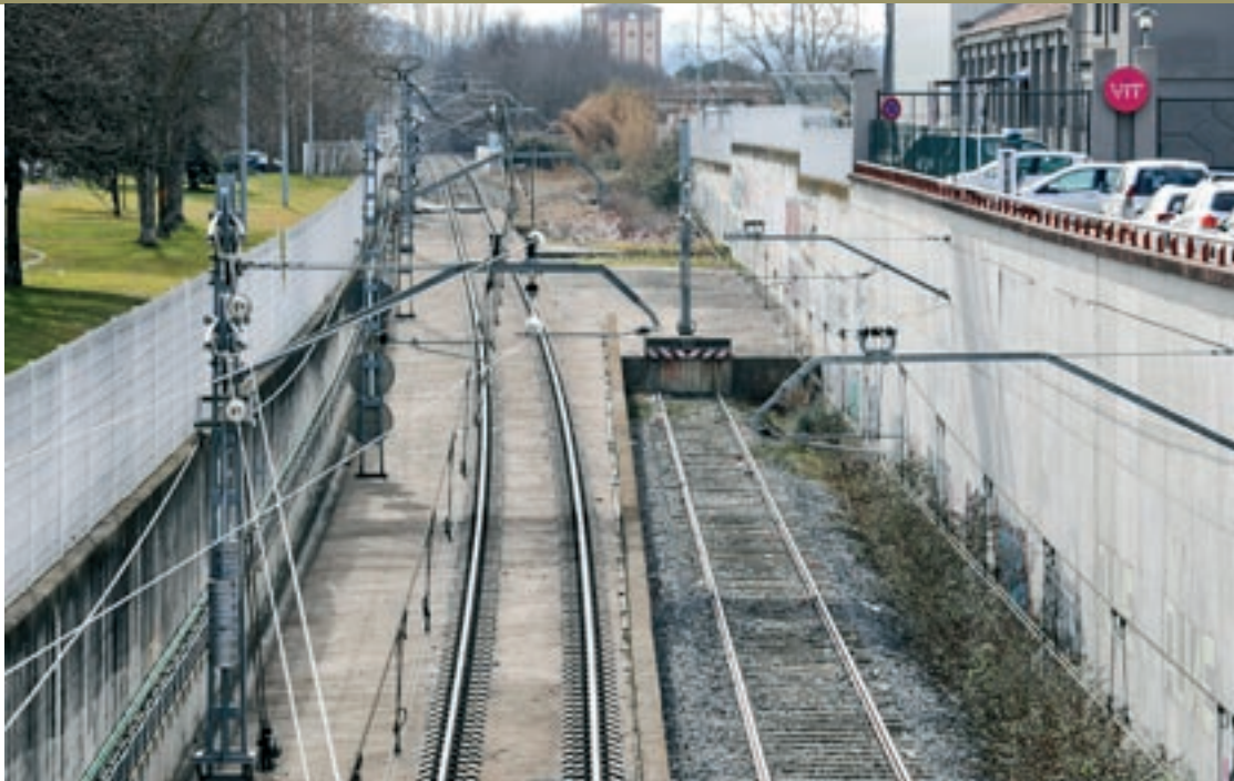
A la imatge, el topall actual que hi ha a Vic i que es preveu allargar en 1,1 quilòmetres en direcció a Barcelona
