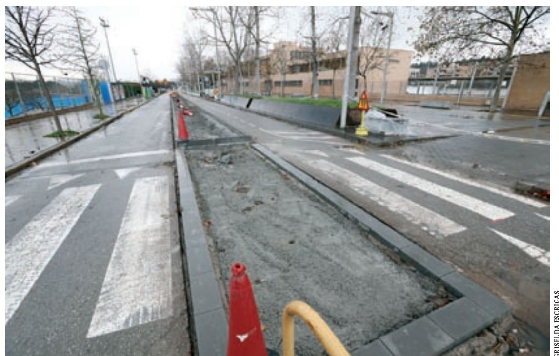
Els treballs de construcció a mig fer de la mitjana central que donarà més seguretat als vianants a l'hora de travessar
