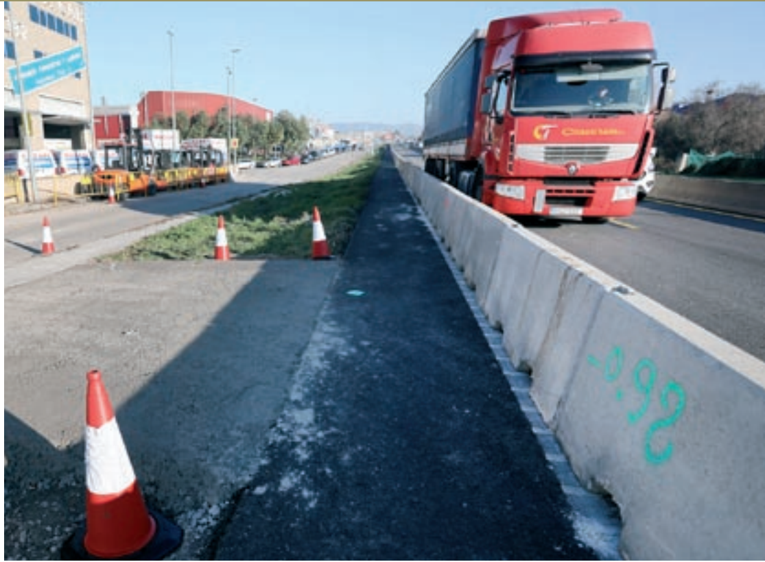
A banda de reduir l'amplada dels dos carrils, s'han col·locat tanques de formigó per separar la zona d'obres del trànsit
