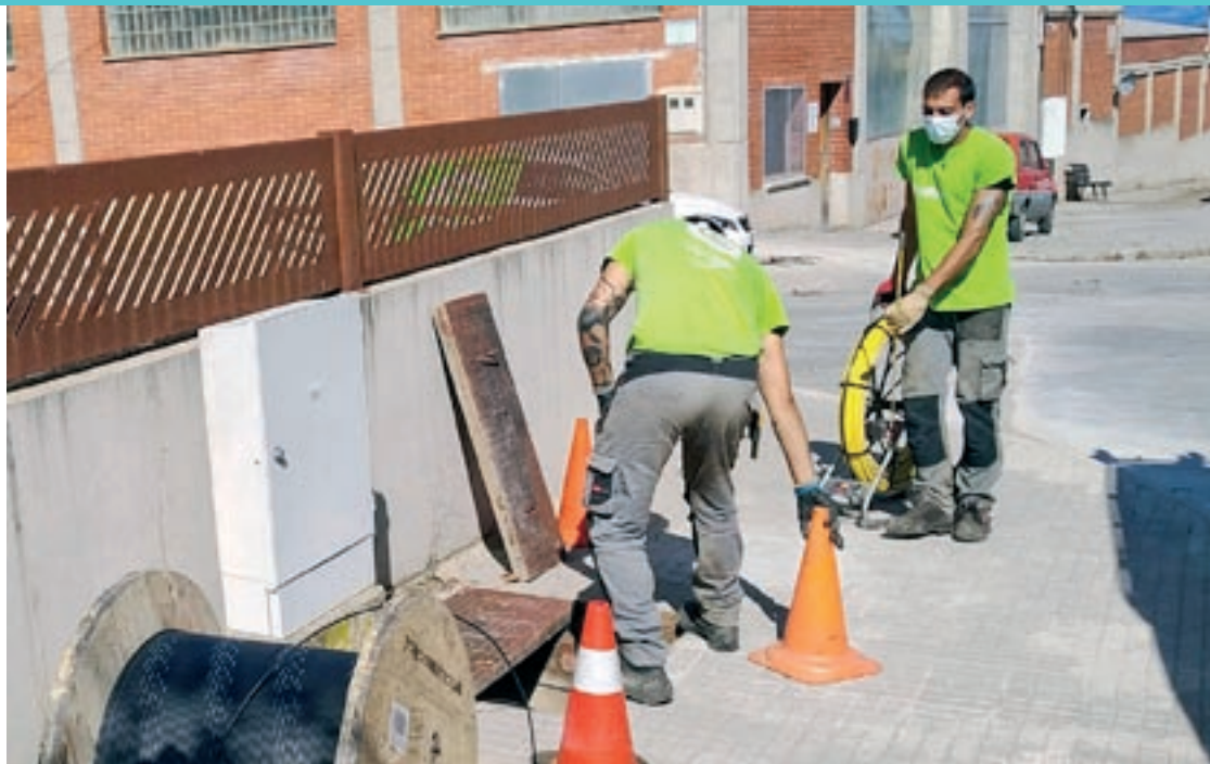
Operaris de Goufone treballant en la instal·lació del cablejat de la fibra òptica
