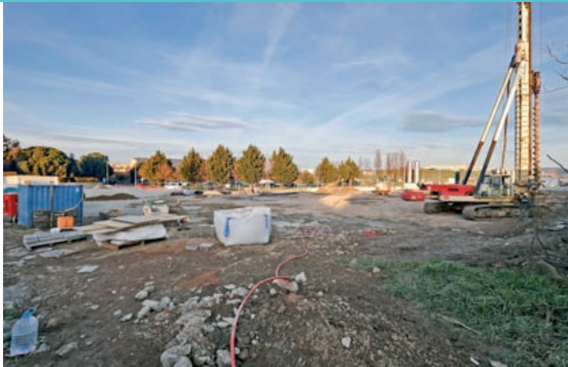
En aquest terreny, a 50 metres de la seu central, es fan ja les obres del nou edifici d'oficines de l'empresa
