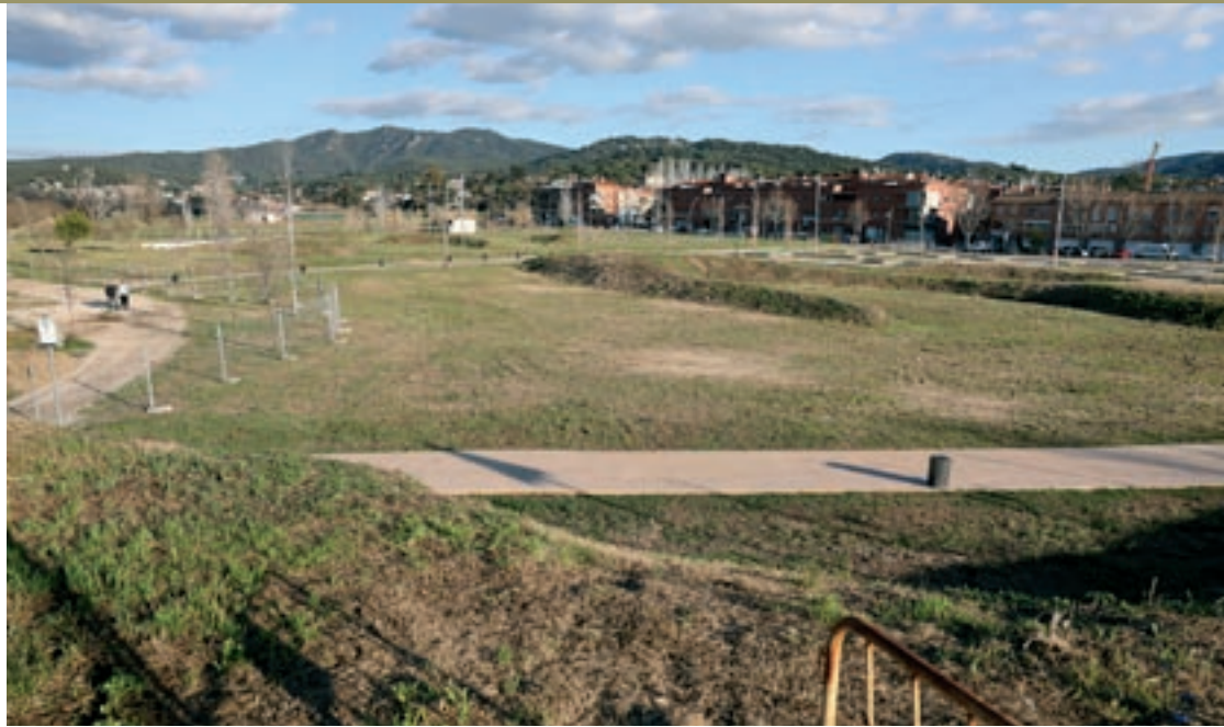
Les obres del parc fluvial de Vilanova s'havien adjudicat a Voracys, SL, però es van aturar el juliol del 2019
