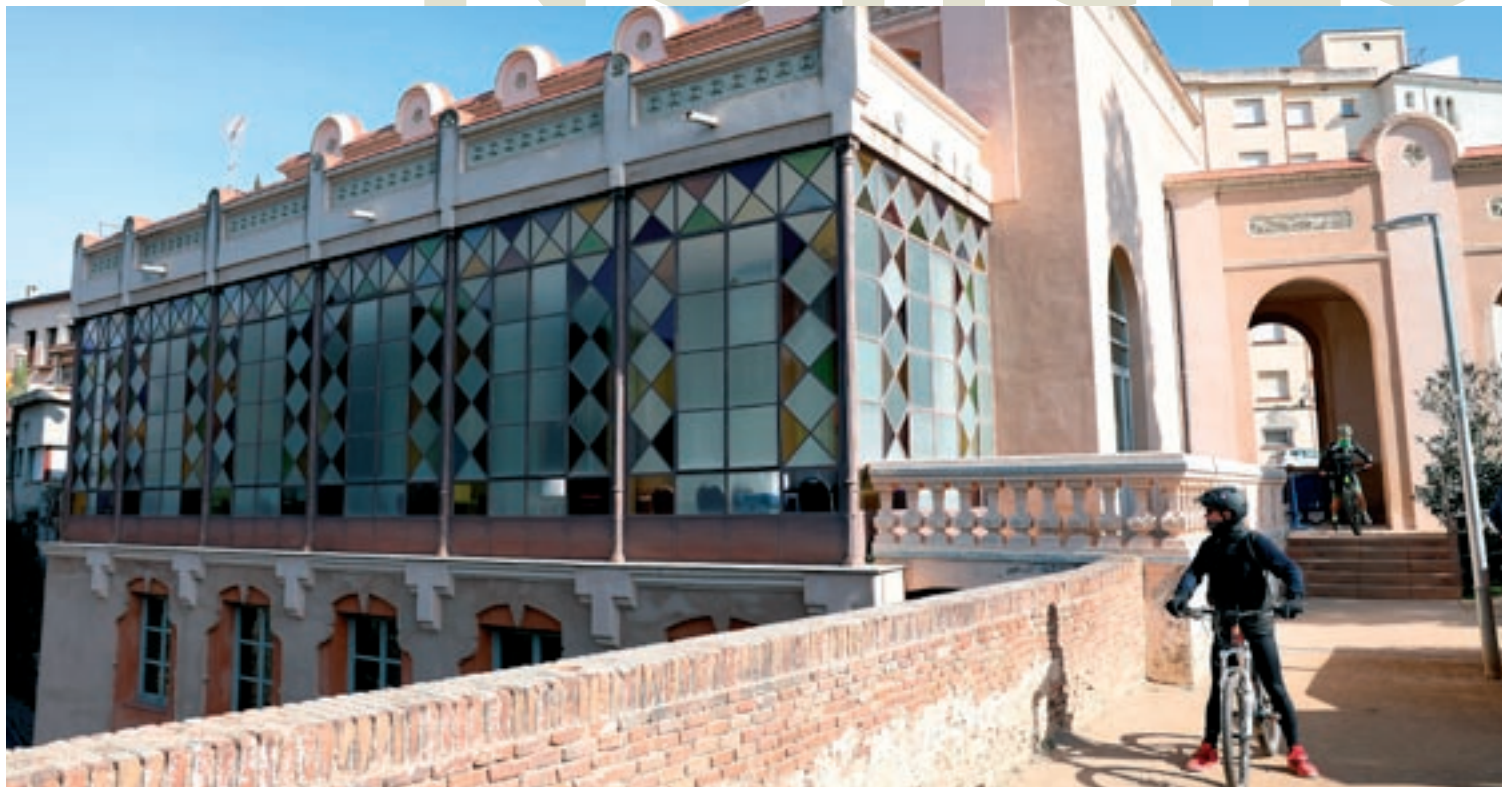
El pont que uneix l'edifici de Can Rius amb el parc del mateix nom, una de les reformes principals de l'antic complex termal del segle XIX
