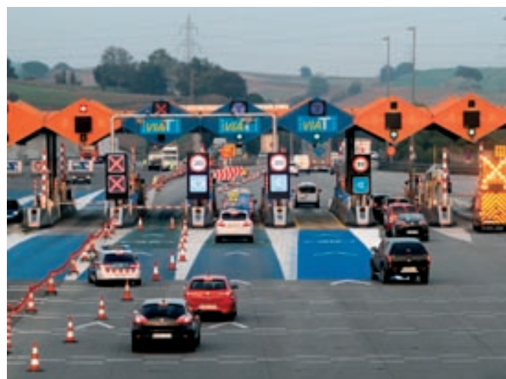
La barrera de la Roca, un dels peatges de la concessió que acaba aquest agost
