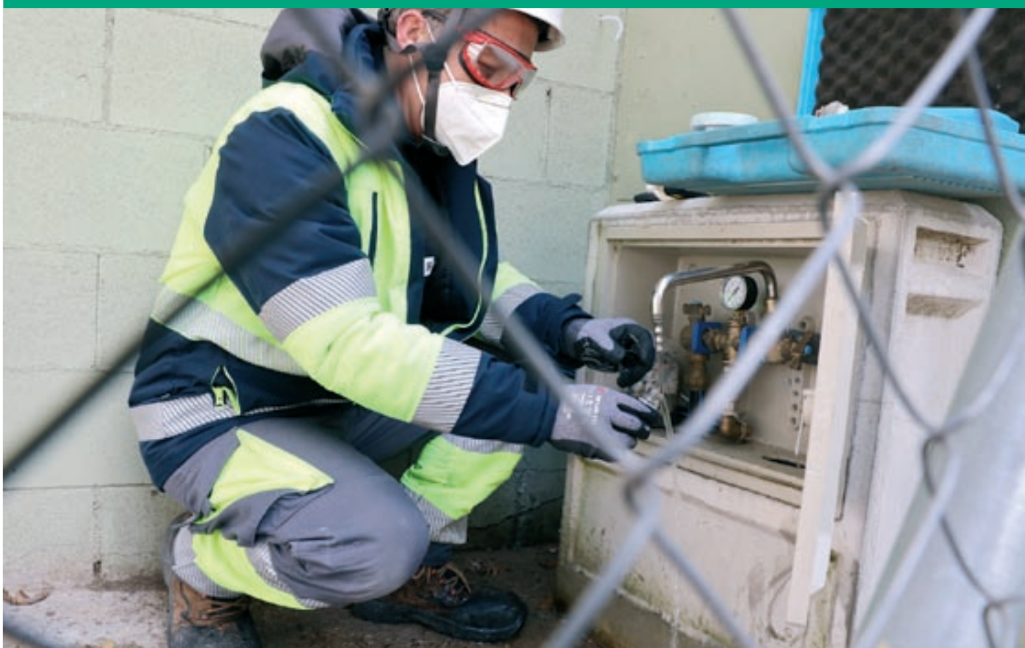
Un operari de Sorea treballa aquest dijous al dipòsit d'aigua del parc del Puig de les Forques, a Granollers
