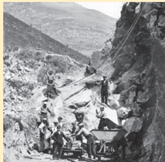
Obrers construint la línia el 1929
