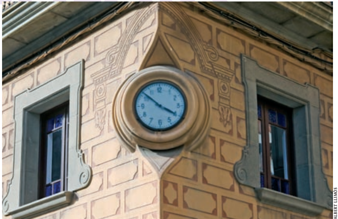
Un detall del rellotge, instal·lat al mateix vèrtex de l'edifici l'any 1945
