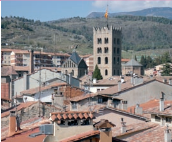
Ripoll vol promoure l'ús d'energies renovables en edificis
