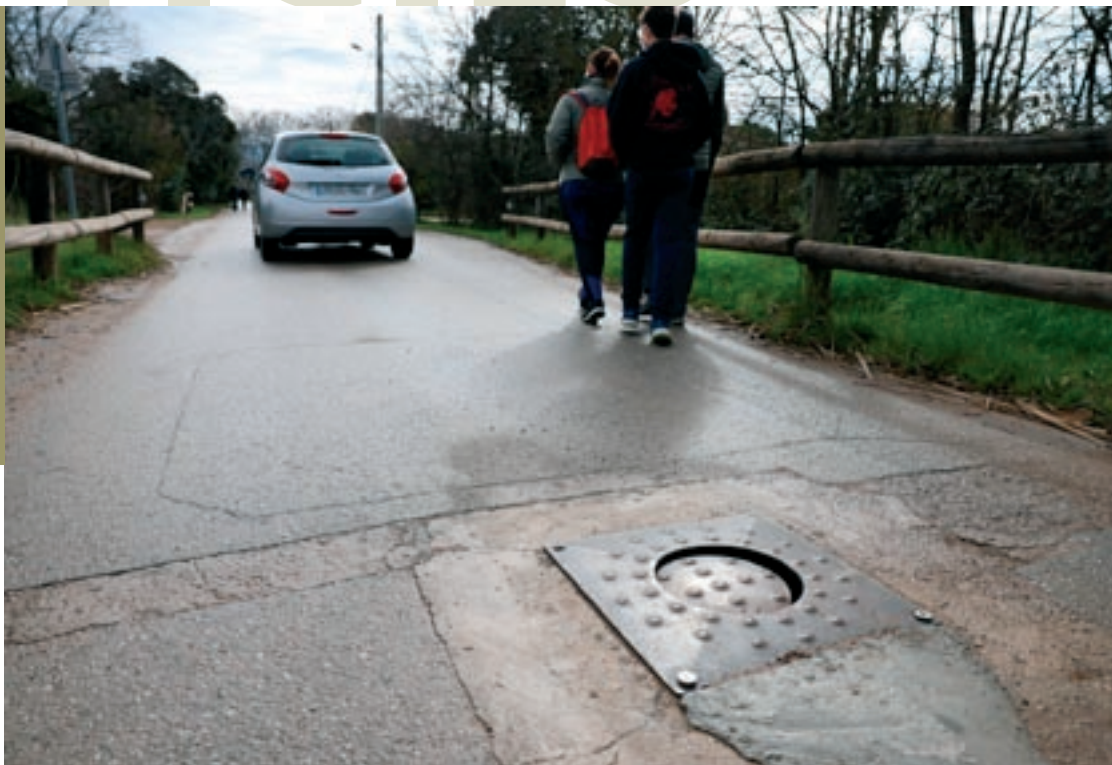
Uns vianants i un vehicle passen per la carretera de Gallecs a l'alçada de la pilona
