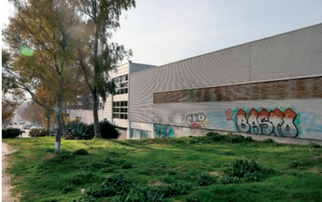
Les instal·lacions de la brigada municipal d'obres de Mollet, al final del carrer Francesc Ferrer i Guàrdia
