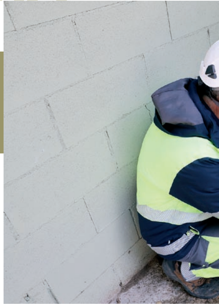
Un operari de la companyia Sorea treballa, aquest dijous, en un punt de la xarxa al dipòsit d'aigua.
