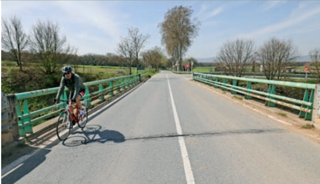
Un ciclista, aquest dimecres al pont de l'Eix a Vilalleons, justament on es construirà la passera metàl·lica
