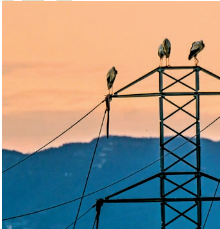
Cigonyes fent parada en torres elèctriques d'Osona aquest mes de març. A les imatges de la dreta.
