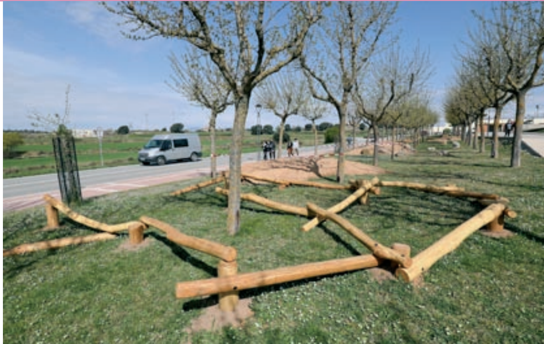
Estat de les obres, que van començar el passat mes de març
