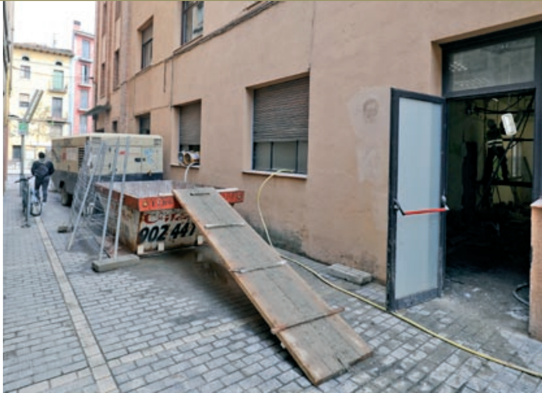
Els operaris han començat les obres aquesta setmana
