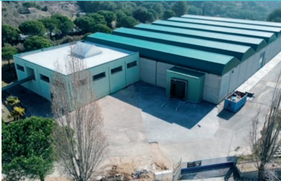
Imatge aèria de les noves instal·lacions de 4.000 metres quadrats que Suquipà ha construït a Sant Feliu
