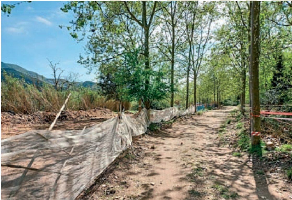
L'impacte de l'entrada de la maquinària és ben visible a l'entorn de la pollancreda propera al peatge de la Llagosta
