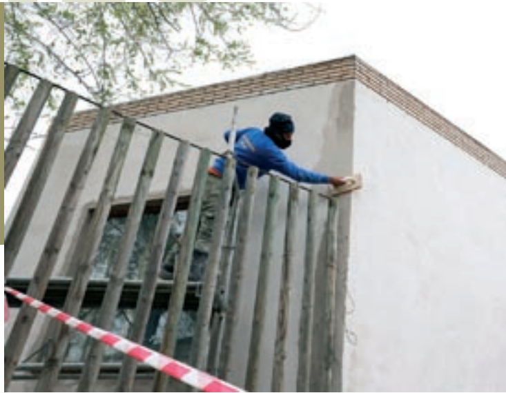
Obres a l'antiga escola bressol per reparar els danys estructurals
