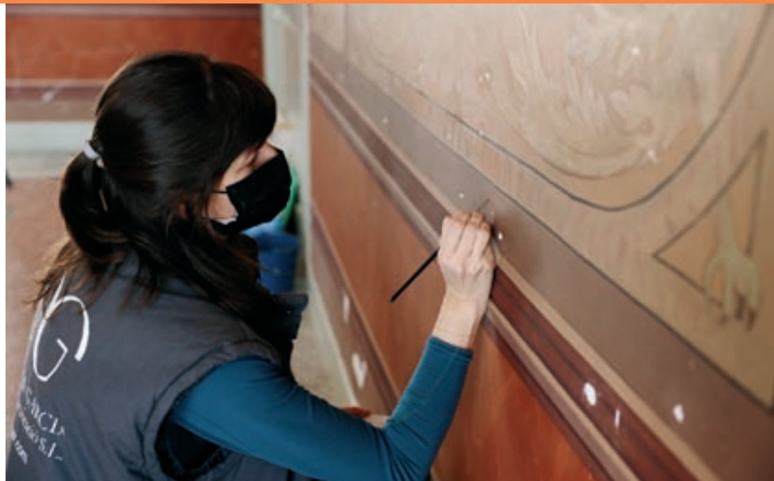
Treballs de restauració de les pintures de Can Rius
