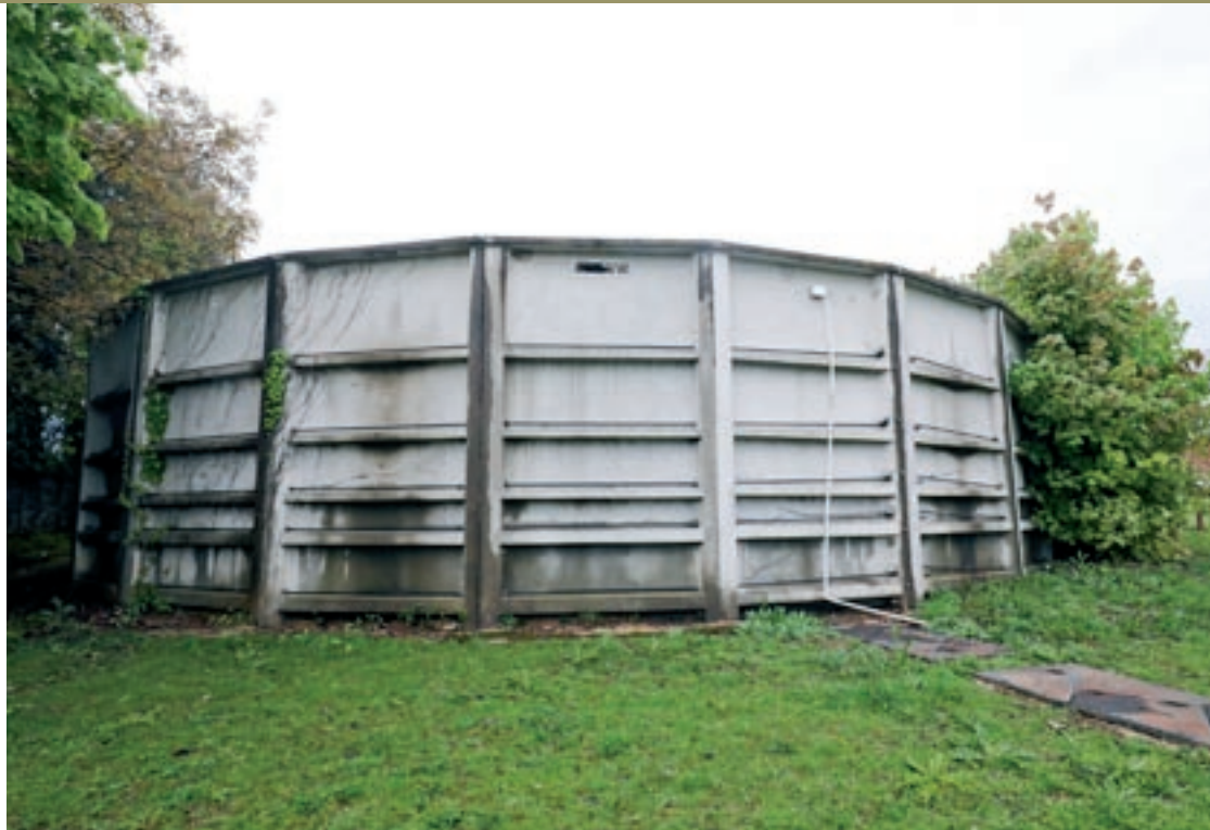
El dipòsit de reserva es va instal·lar al costat del convent de les monges, però no té connexió a la xarxa
