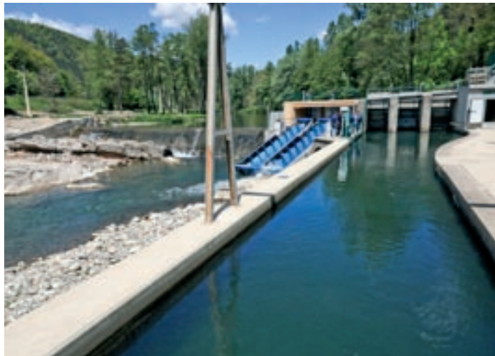
Corba de Ripoll. A dalt a la dreta, l'escala de peixos. A sota en primer terme, el canal i al fons, els cargols i la resclosa
