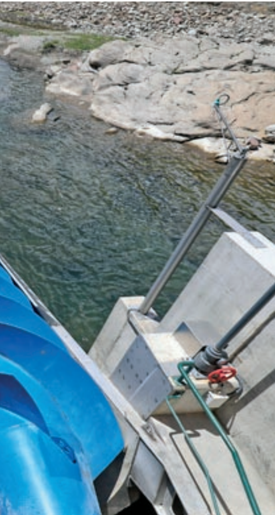
Corba de Ripoll. A dalt a la dreta, l'escala de peixos. A sota en primer terme, el canal i al fons, els cargols i la resclosa
