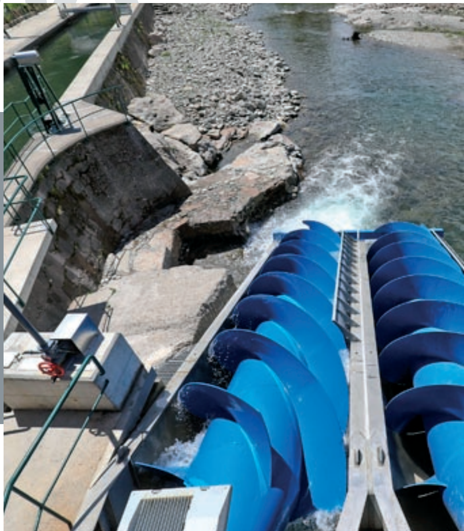
A l'esquerra, els dos cargols d'Arquimedes que s'han instal·lat a la resclosa de la central de la Corba de Ripoll
