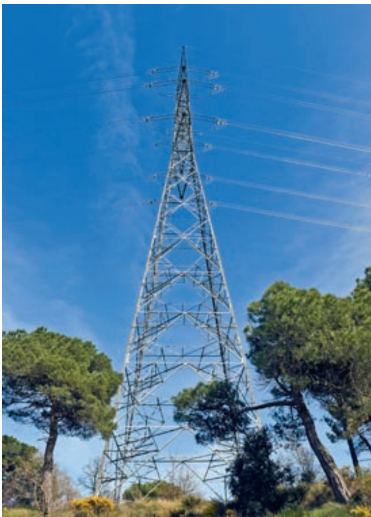
Una torre de la MAT, en terme del Brull
