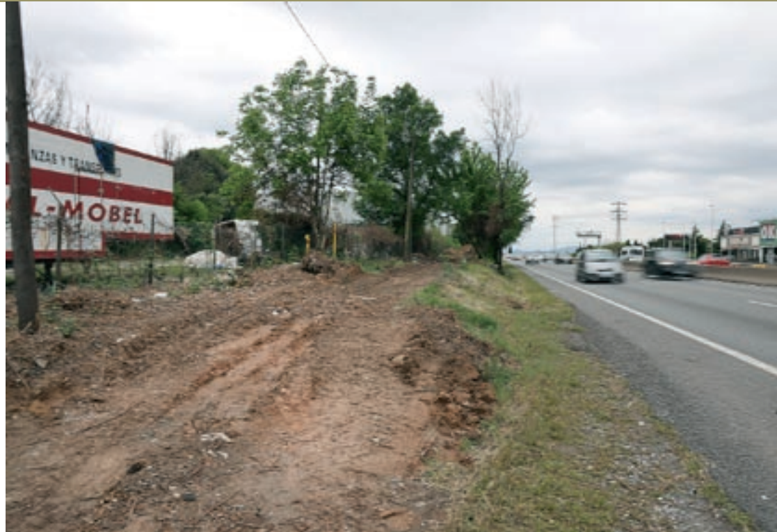
Al costat de la C-17 ja fa algunes setmanes que es fan treballs de desbrossament, al terme municipal de Parets
