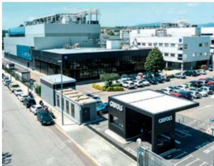
Aspecte d'un dels espais del complex productiu de Grifols a Parets
