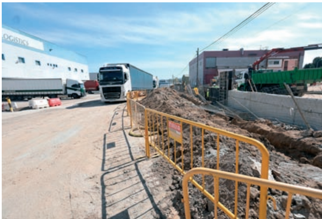
Les obres de millora del polígon de la Font del Ràdium de Granollers es van desenvolupar durant l'any passat
