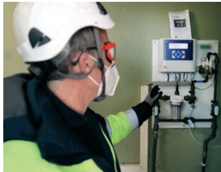
Un operari d'Agbar en un quadre de control d'un dipòsit de Granollers
