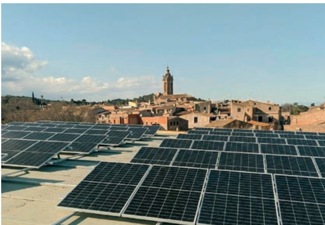
Una de les instal·lacions que formen part de la comunitat energètica que engegarà properament
