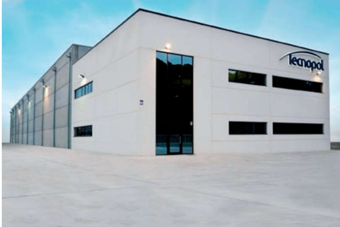
L'actuació inclou la construcció d'una nova nau, a la qual, entre d'altres, es traslladarà el magatzem de la planta
