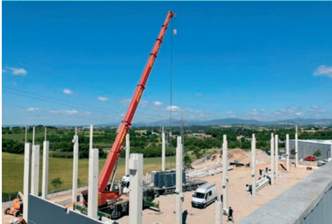
Els treballs de construcció de les naus de la segona fase de la implantació de Frime a la Roca ja estan en marxa
