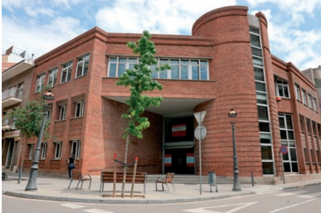
L'edifici del carrer Verge de Núria acollirà els apartaments de la Mútua si els socis n'aproven la compra
