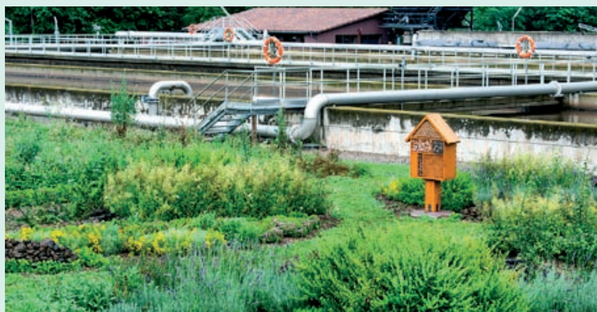
Jardí de papallones a la depuradora d'Olot
