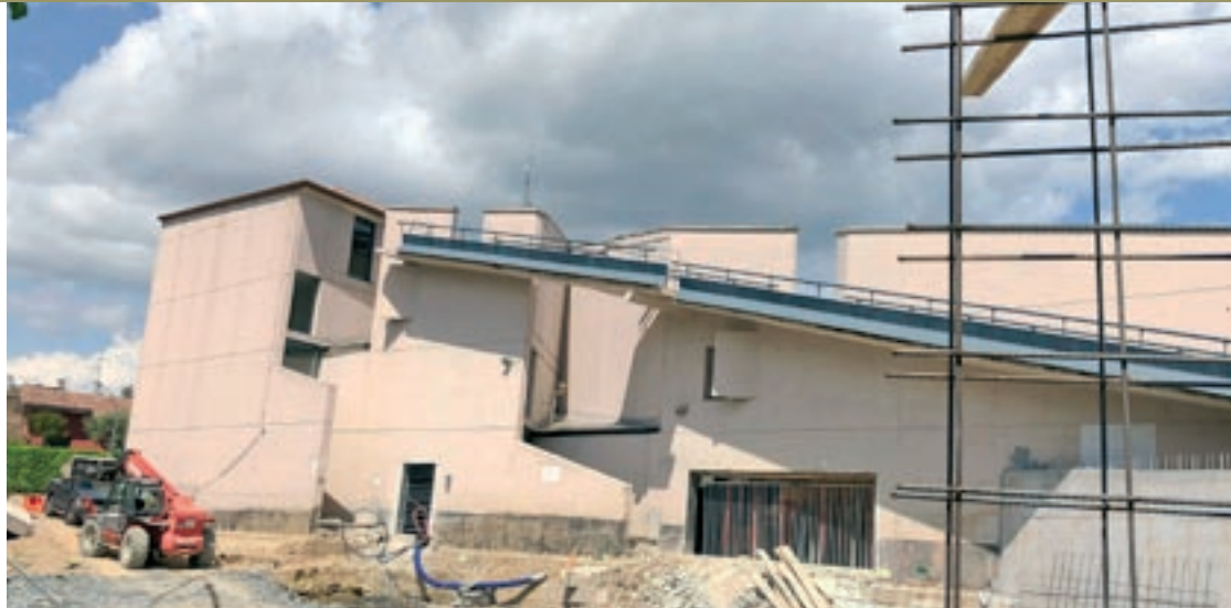
A l'edifici de La Pista s'hi estava treballant aquest dijous, com des de fa mesos, tot i que el projecte es va aprovar dilluns
