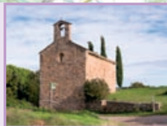
Església d'origen romànic reformada al segle XVI d'estil gòtic tardà. Edificació aïllada d'una sola nau rectangular acabada en absis semicircular, amb elements clarament romànics. Sembla que la capçalera i la nau es van construir als volts de l'any 1080 i fou reformada o modificada al segle XII. L'última restauració data del 1980.
