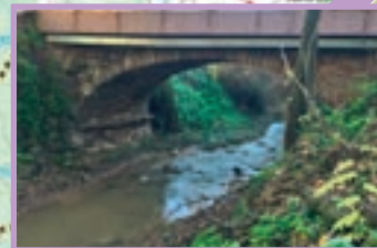
Pont a Santa Eulàlia de Riuprimer Antic pont sobre el riu Mèder, d'un sol arc, de pedra. Actualment està recobert per una estructura de construcció recent.
