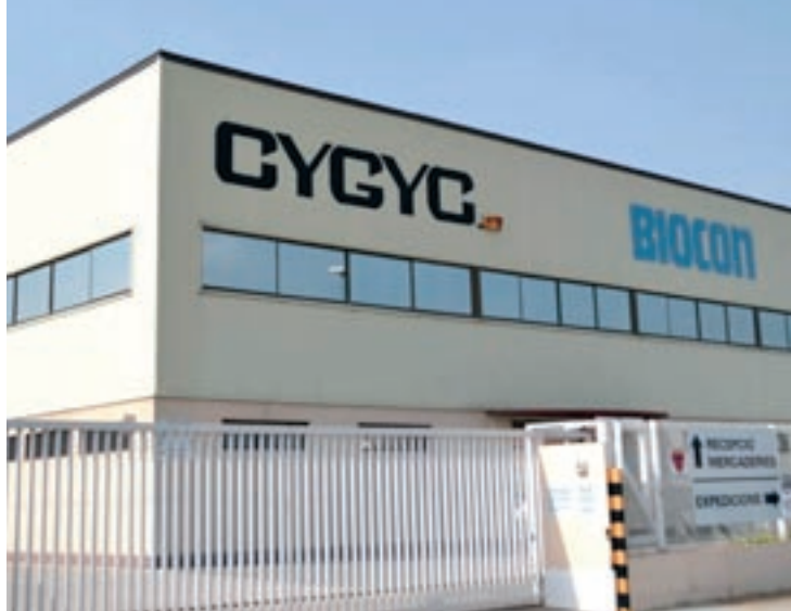
L'empresa ha ampliat les instal·lacions del polígon del Pla de Llerona
