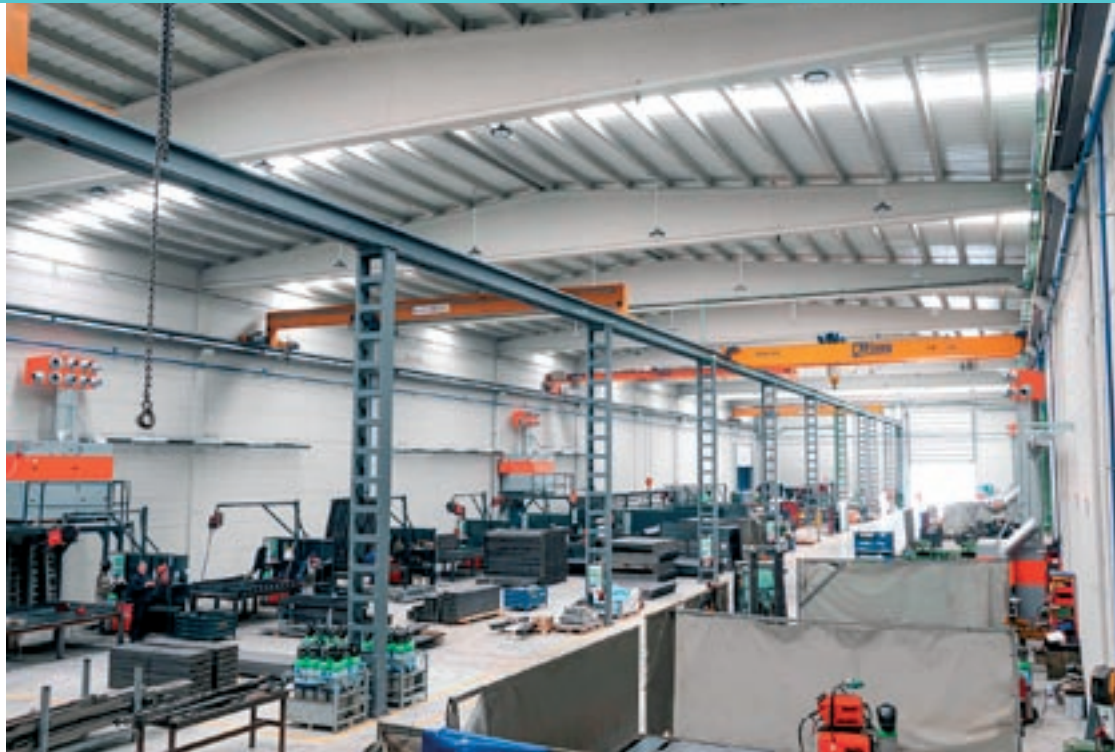
Interior de les noves instal·lacions que Inkema ha posat en funcionament recentment a les Franqueses
