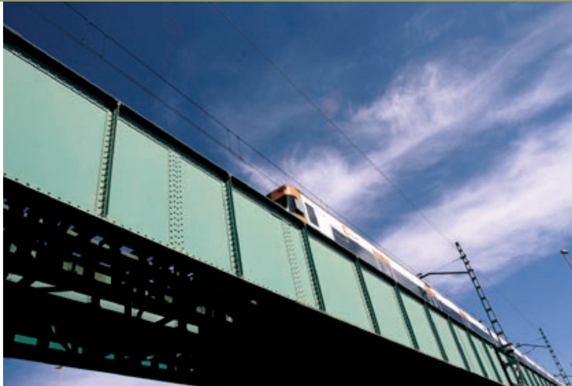
El pont de l'R3 entre els termes municipals de Canovelles i les Franqueses, part del tram on s'estan fent les obres
