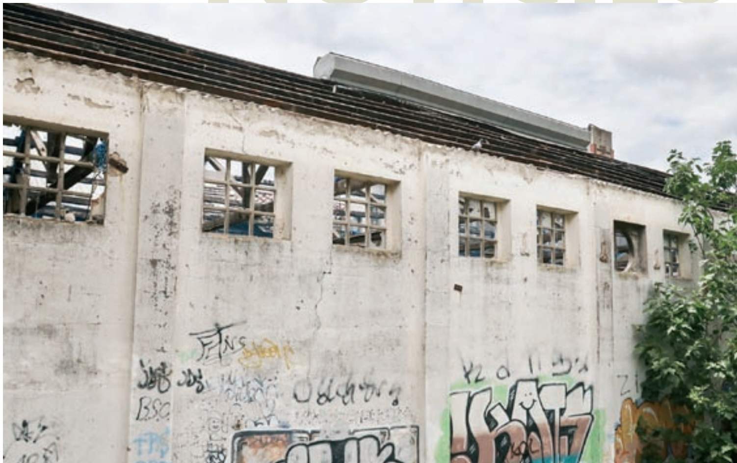
Les obres d'enderroc de l'antiga Lefa de Mollet han començat per la part del sostre
