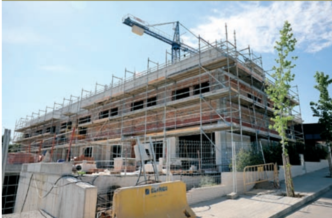
Un bloc de pisos en construcció al sector de Can Draper, a l'entrada de l'Ametlla des de la C-17
