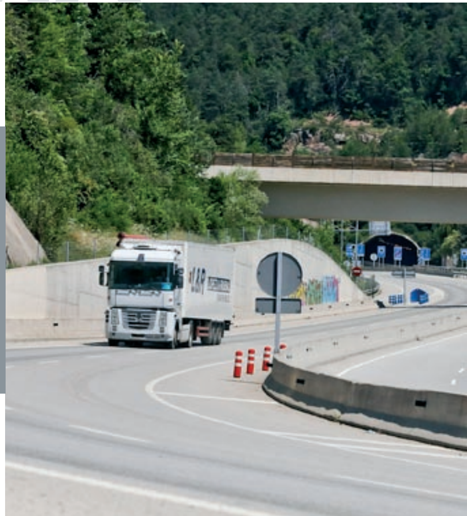
Estat actual de la carretera C-17 en el seu pas per la Farga de Bebié
