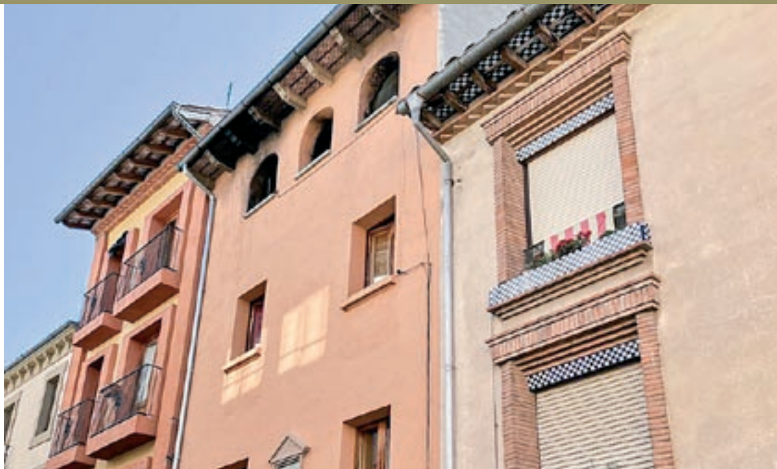
L'incendi es va produir al pis superior d'un habitatge ubicat al carrer Sant Francesc de Vic
