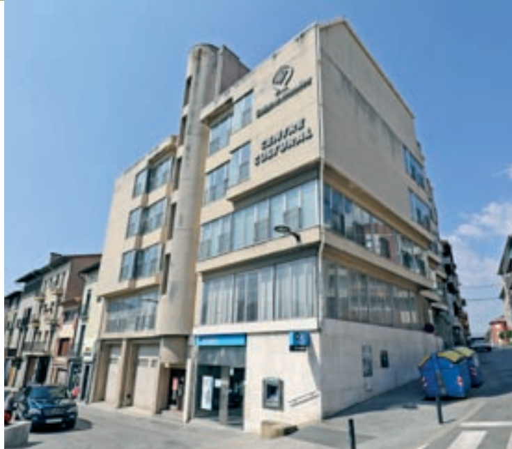
Vista general de l'edifici de l'antic centre cultural Caixa Manlleu
