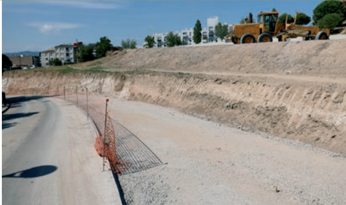
Treballs d'adequació dels terrenys del sector W que serviran com a aparcament públic per a l'Hospital de Granollers
