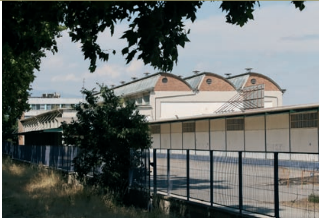
L'antiga fàbrica Fredenhagen, al polígon de Can Prat, és un dels edificis que s'incorpora al catàleg de Patrimoni
