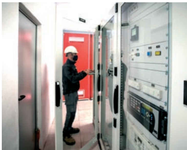
Interior de la subestació que ha construït la companyia a Vic
