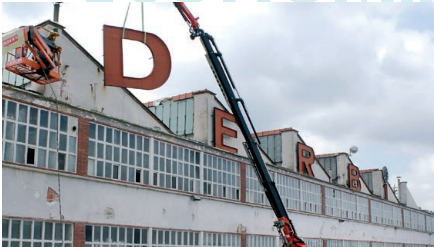
Uns operaris retiren les lletres d'una de les façanes de les instal·lacions de Derbi on han començat els treballs d'enderroc
