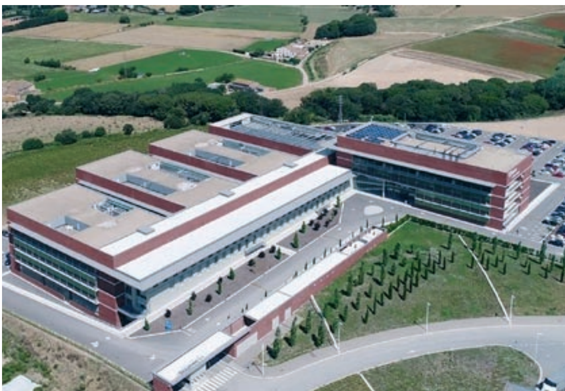
Vista aèria de les instal·lacions de Biokit (ara Werfen) a Lliçà d'Amunt
