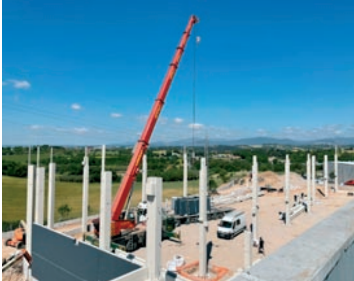
Obres de construcció de la planta de Frime a la Roca
