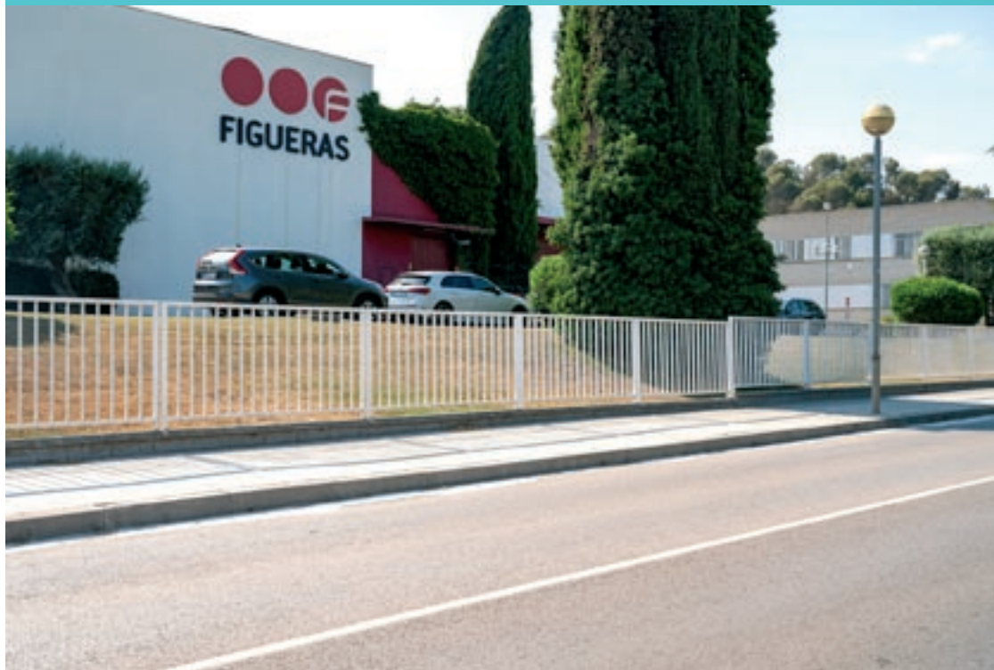
Les instal·lacions de Figueras a Lliçà d'Amunt augmenten l'ocupació amb la incorporació de Carandini
