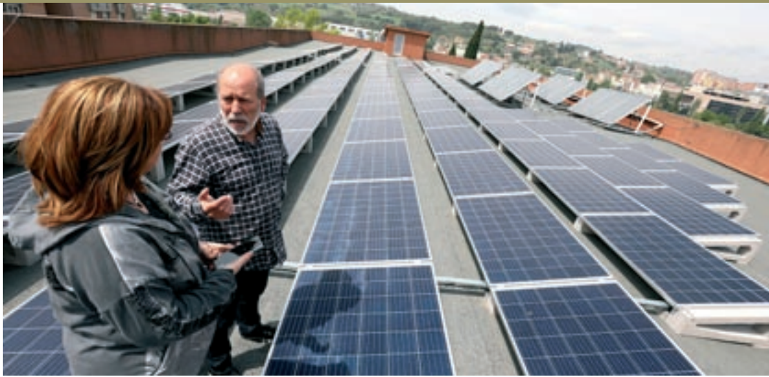
Una de les dues instal·lacions de plaques fotovoltaïques que ja hi ha a les cobertes de l'EMT, a Granollers
