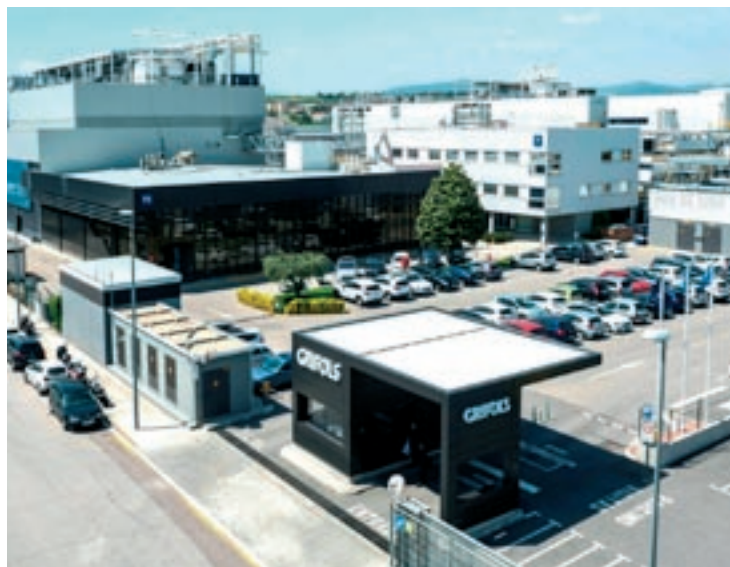
Instal·lacions de Grifols a Parets
