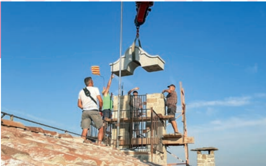
Per col·locar la pedra del campanar d'espadaña es va fer servir un camió grua
