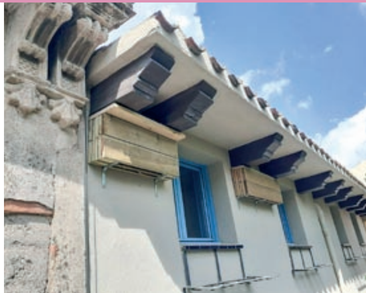
Algunes de les caixes niu instal·lades a l'edifici del Casal d'Avis
